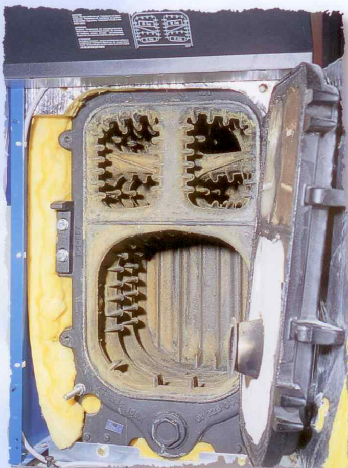
Chaudière après le nettoyage alcalin.
